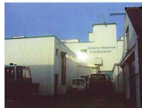
Voorzijde ijsfabriek vanuit Brouwerstraat
